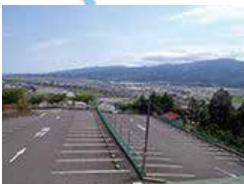
駐車場の様子
